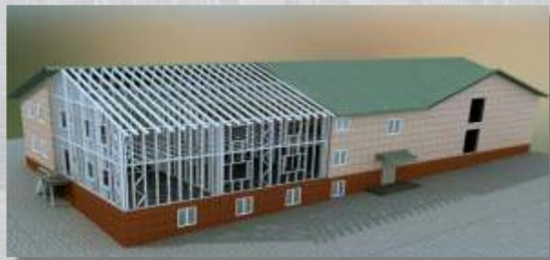
Большепролетные конструкции строят из быстровозводимых металлоконструкций ЛСТК с шириной пролёта от 12м и более.
